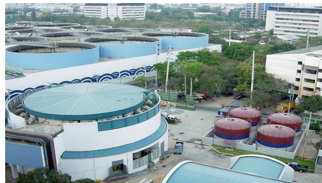
Dindang WWTP , Bangkok
