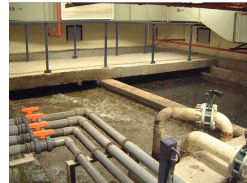
VCB bldg, Hanoi
