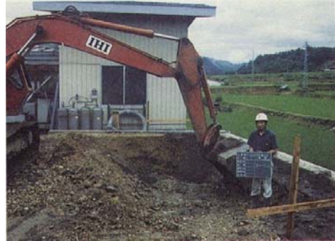
③掘削工事
