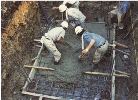
⑤底版コンクリート工事
