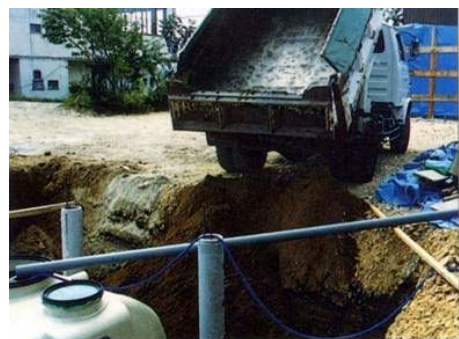
⑧埋め戻し工事
