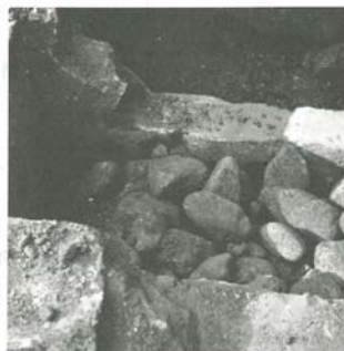
▲第2槽 玉石が詰まっています、生物処理がなされた。
