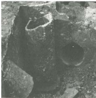
▲第1槽 し尿が左の土管から流入。沈殿分離して第2槽へ。中央の縦の土管はシステムとは関係ない。
