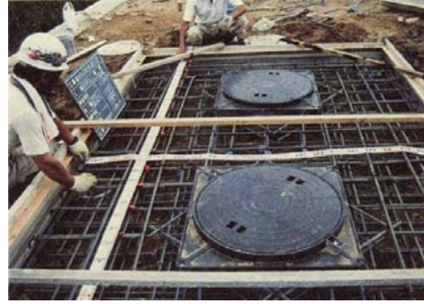
⑩コンクリートスラブ工事
