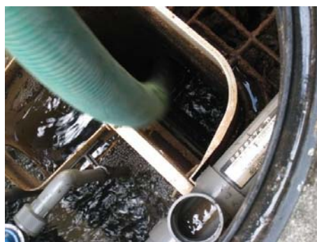
嫌気ろ床槽第2室の汚泥の引き抜き
