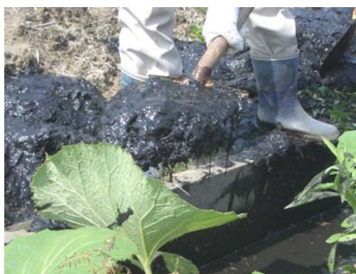
写真5-1 腐敗した川のどぶさらいの状況 （底部は黒色化したヘドロで一杯です）
