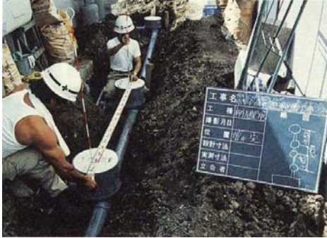
⑨配管の接続
