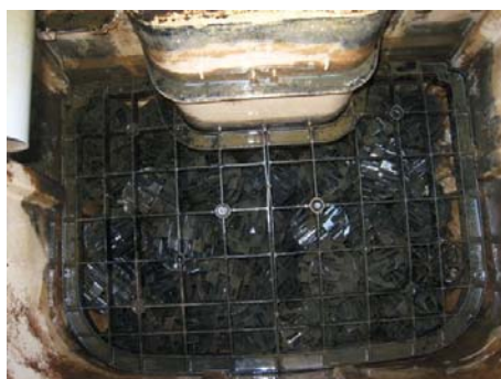
引き出し後の槽内の状況
