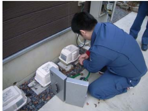
ブロワの点検
