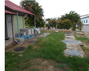
Canteen & toilet (Myanmar: 30m 3 /d)
