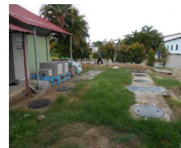
Canteen & toilet (Myanmar: 30m 3 /d)
