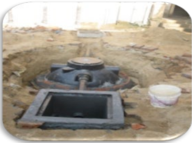
PACKAGE ANAEROBIC FILTER ( 191 mg/L-60 %)
